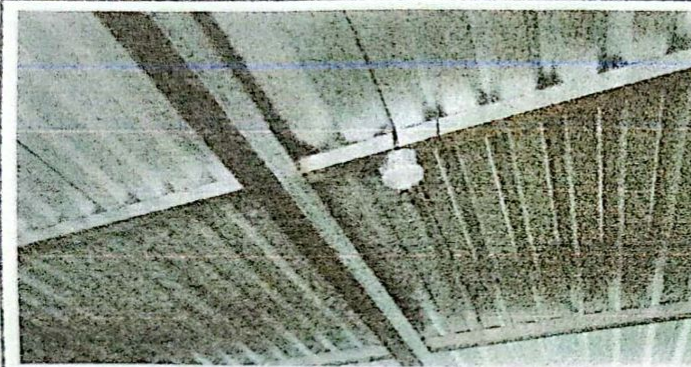
Foto 3: CUBIERTA DE LAMINA
